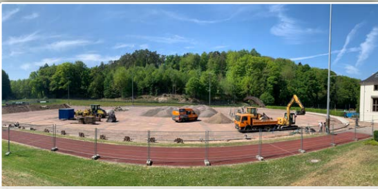
Schweres Gerät bei der Sanierung von Platz 1.
